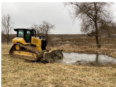
Temporäre Gewässer werden erneuert
